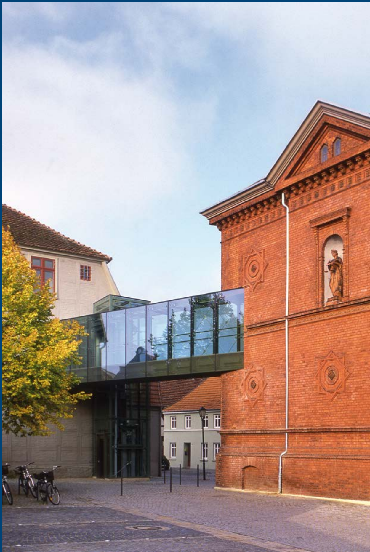
/Verwaltungssitz Malchow, barrierefreie Verbindung von denkmalgeschütztem altem Rathaus und denkmalgeschütztem ehemaligem Amtsgericht (Autzen & Reimers Architekten BDA)
